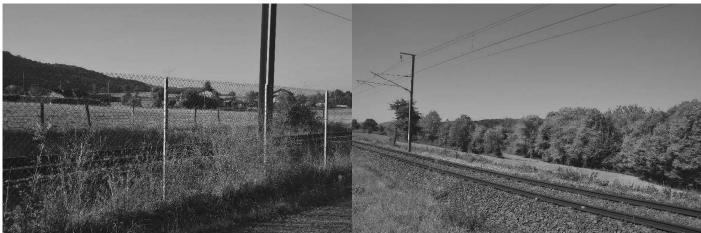
Voie ferrée avec clôture métallique (sud de Curfin) et sans clôture métallique (nord de Curfin) (photos Luc Laurent)
