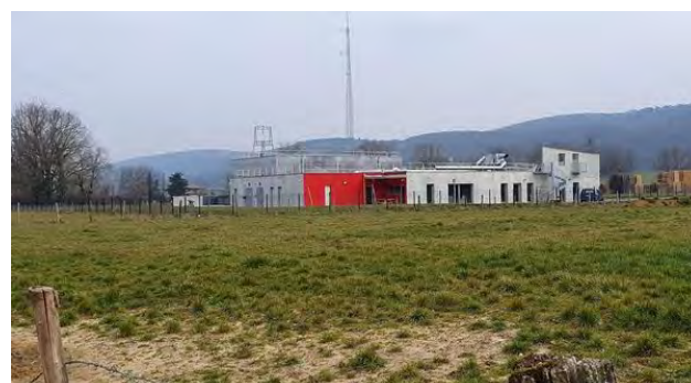
Le centre d'incendie et de secours du Suran
