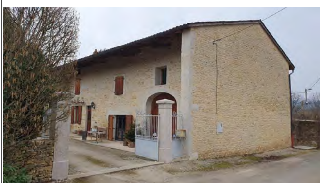
64. Un exemple d'éléments remarquables sur un bâti de qualité restauré : conservation des proportions des ouvertures et volumes existants, encadrements en pierre, voûtes de grange, mur pignon Nord en saillie de protection, piliers de l'entrée en pierre
